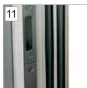
Przegroda termiczna, dwie uszczelki w ościeżnicy
