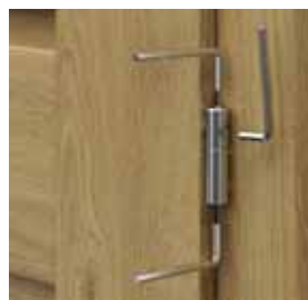
regulacja zawiasów czopowych regulowanych 3D
