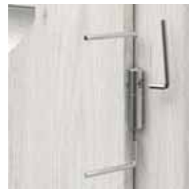
regulacja zawiasów czopowych regulowanych 3D
